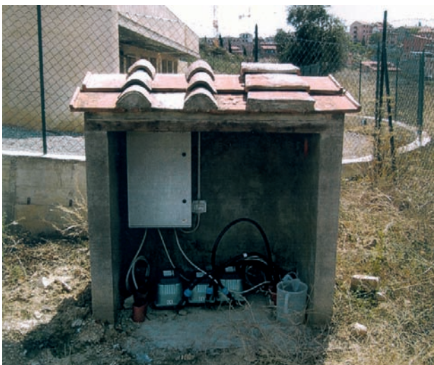
ESEMPI DI LOCALI TECNICI IN CLS
