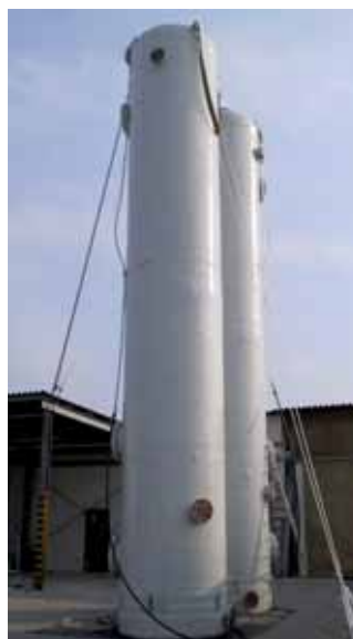
COLONNE DI STRIPPAGGIO ALTEZZA 11 m
